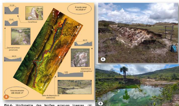
Fig. 4- Morfometria das feições erosivas lineares. (A) Voçoroca do Barata e (B) Cavidades marginais da atividade garimpeira diamantífera (desmonte do relevo).
